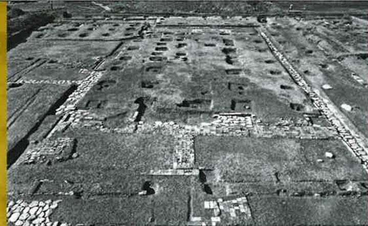
発掘調査時の様子(南棟付近東から西方向/長方形のものが塼)
